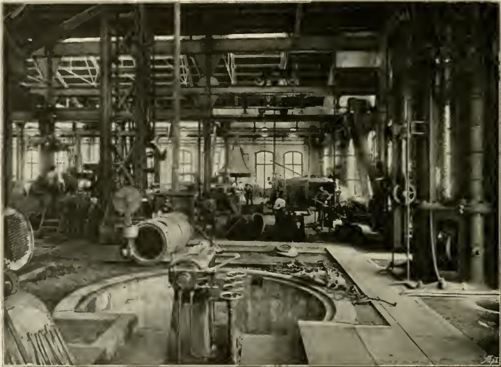
Abb. 36a. Werkstätte Linz der k. k. österreichischen Staatsbahnen. [Kesselschmiede und Blechbearbeitungswerkstätte, im Vordergrund fixe hydraulische Nietmaschine.]
